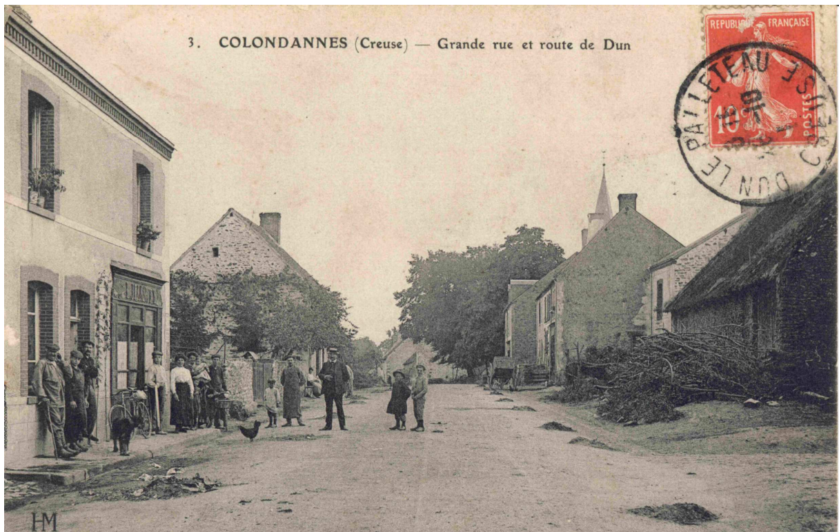
Vue de Colondannes vers 1910. Sur la droite, au premier plan, une grange couverte en chaume.
