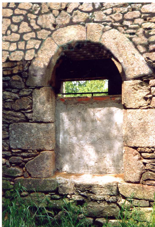
Sur la face arrière d'une grange dans le milieu du village, un encadrement de porte en réemploi qui semble provenir de l'ancienne église du Cros.
