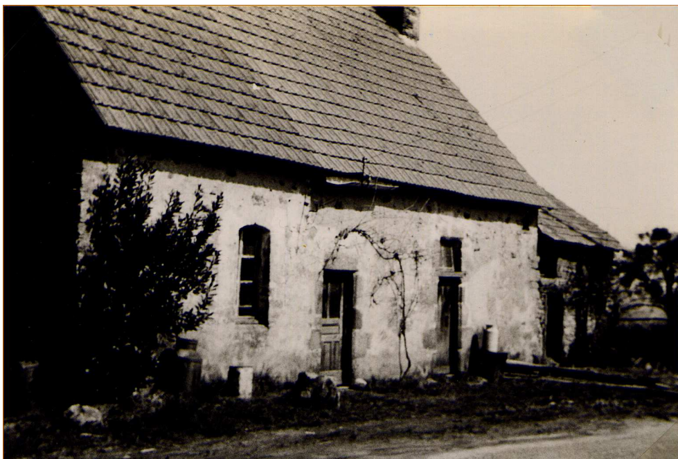
Les vieilles maisons, à l'origine couvertes en chaume, puis en petites tuiles plates, en tuiles mécaniques ou en ardoise, ont quelquefois conservé leur pente d'origine comme celle-ci.
