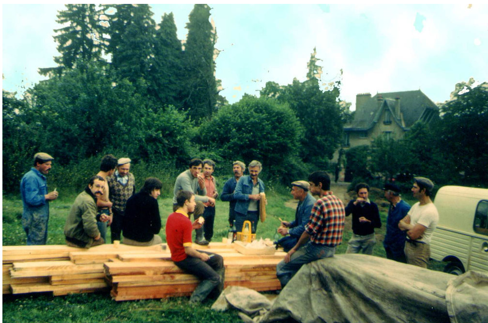
Après l'effort, le réconfort ! Casse-croûte sur le chantier.
