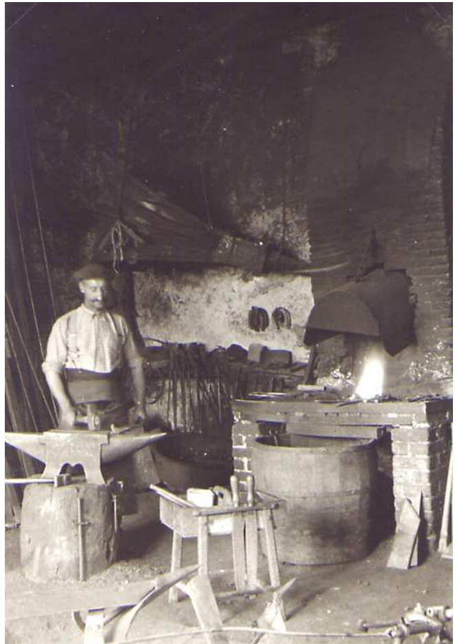
Adrien Gomme devant son enclume, dans son atelier de forgeron. Sous la forge, le bac en bois qui servait pour la trempe des outils en acier.
