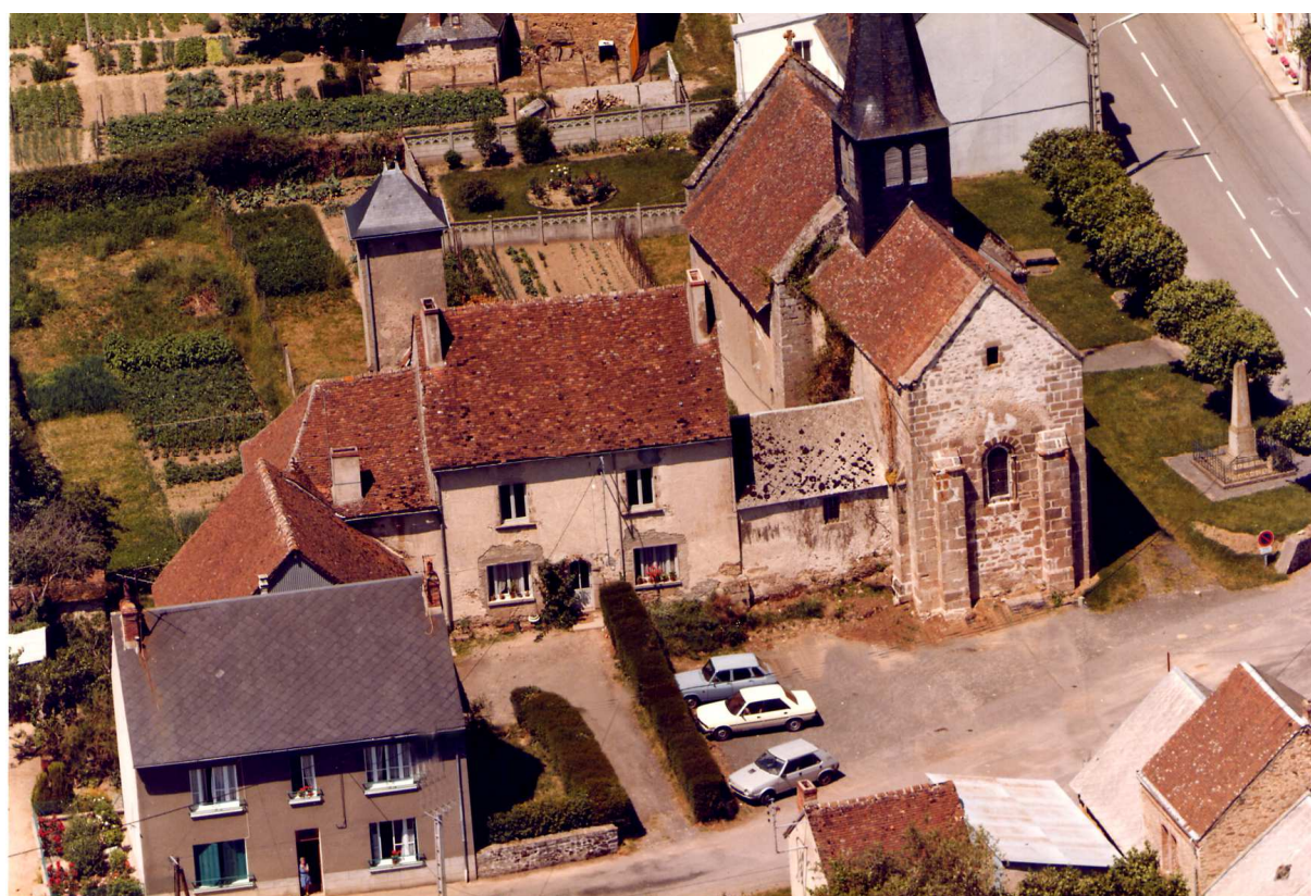
Eglise et presbytère. Vue aérienne fin des années 1980 (photo Hélicolor).
