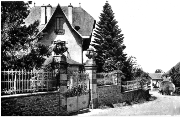
La villa Maria, route de Naillat à Colondannes.
