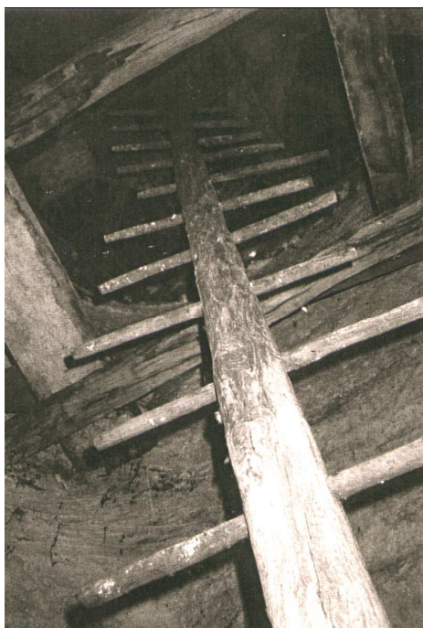
Échelle en bois dans le haut de la tour pour aller au pigeonnier. (vers 1990).
